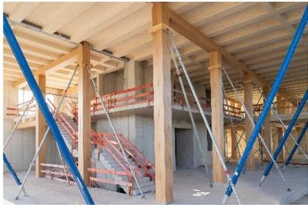
Die Tragstruktur in allen Etagen bilden Stützen und Unterzügen aus BauBuche, die die Holz-Beton-Verbund-Deckenelemente tragen.
