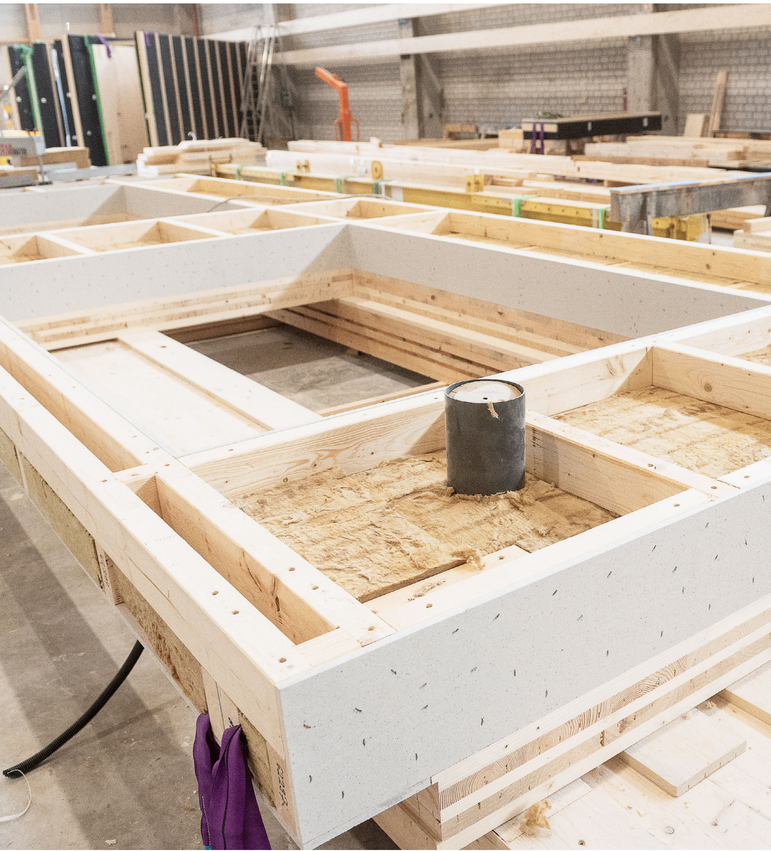
1 LENO®-ADD-Wand auf der Fertigungsstraße
