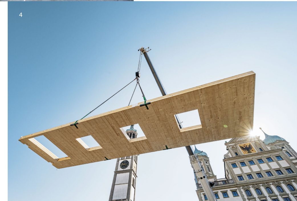
2 KUKA-Roboter-Abbund / 3 Serielle Elemente auf der Baustelle / 4 Next500 Pavillon Fuggerei, Augsburg; © Eckhart Matthäus
